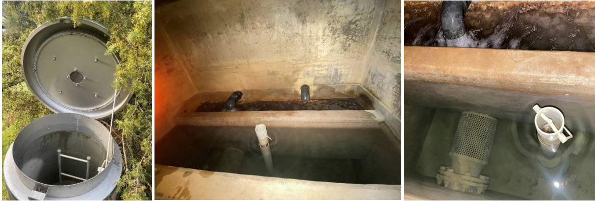
Figure 6 : Chambre collectrice
